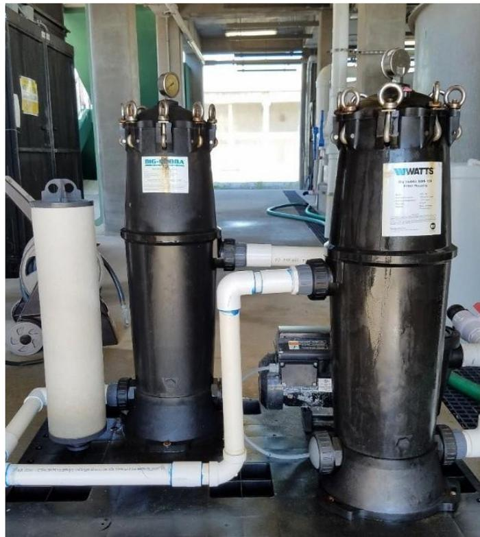
FIGURA 2. Equipo de filtración instalado en un palé con desconexión rápida y accesorios de unión en el Criadero de Investigación de Ostras Louisiana Sea Grant en Grand Isle, Louisiana. Foto cortesía de John Supan
